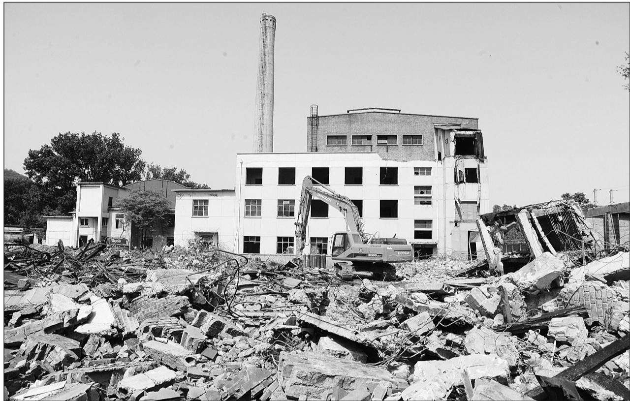
北京市海淀区为鼓励企业煤改气,以每蒸吨5万元的标准给每家企业补助,从今年开始海淀区属3800多台供暖锅炉将改烧天然气。图为中国航空工业集团北京航空材料研究院在拆除燃煤锅炉房。本报记者贾继恒摄
