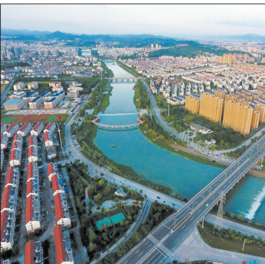
“五水共治”中,浙江省武义县对穿城而过的熟溪河城区段,在河道疏浚、防洪堤衬砌及拦水坝、桥梁设计建造等方面,都做到与水岸景观工程相结合,并对沿岸村庄和老城区实行截污纳管,做到雨污分流。目前武义县已在熟溪河城区段两岸建起生态走廊和十多个广场公园,并安装景观照明,使这座山城透出勃勃的生机与灵气。 中国日报图片网供图
