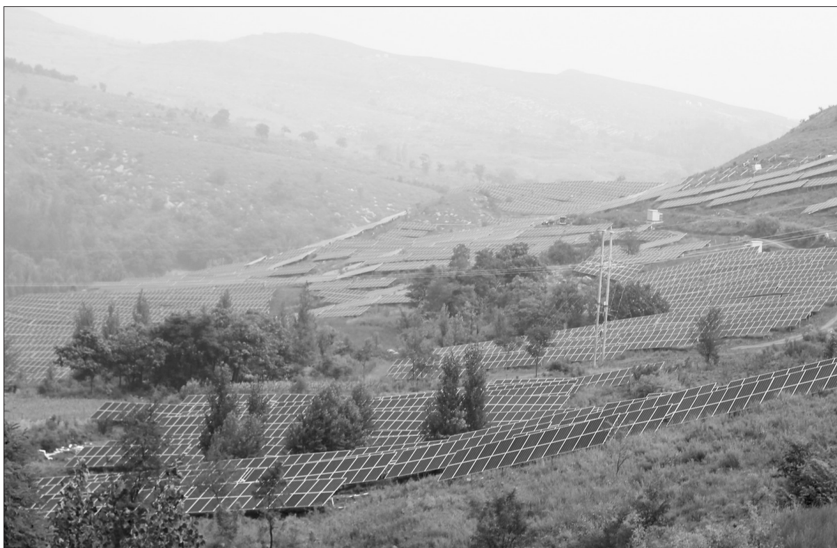
河南省宝丰县充分利用荒山资源,通过招商引资、荒山租赁等形式,在当地闫三湾等村建设100兆瓦光伏发电项目,打造清洁能源。据了解,这一项目总投资8.3亿元,目前已经建成且并网发电,预计年发电量为10900万千瓦时。
