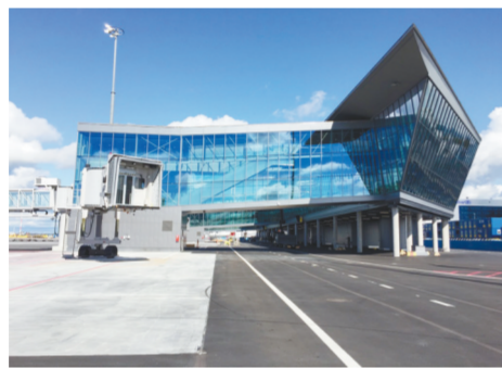
图为赫尔辛基机场扩建区域,建筑多采用玻璃墙体,便于充分利用自然光。
