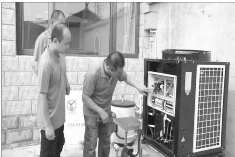
图为技术人员正在村民家里调试空气源热泵。韩继波供图
