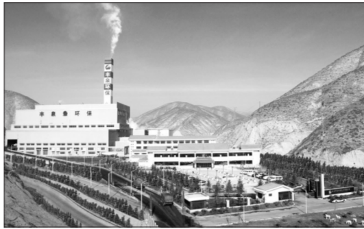
图为甘肃兰州垃圾发电项目。
