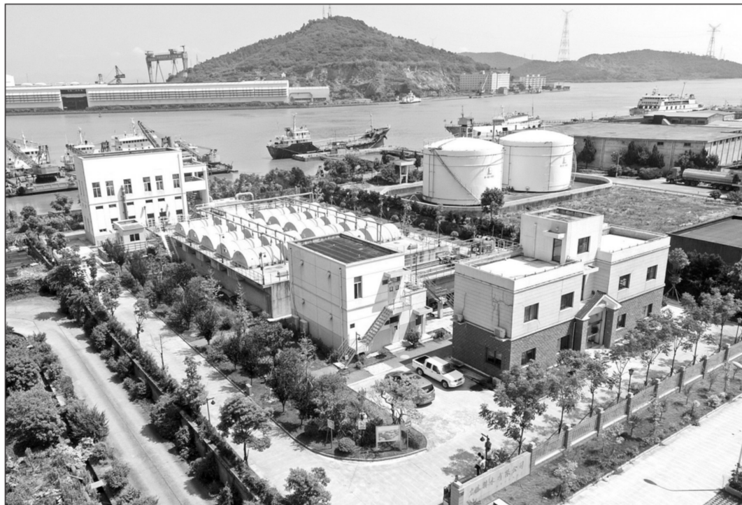
浙江省宁波市目前已投用城镇集中式生活污水处理厂25家,总处理能力191.1万吨/日。图为宁波北仑岩东水务有限公司白峰污水处理厂,为这一项目提供主要设备的是浙江德安科技股份有限公司。据该公司技术人员介绍,为避免二次污染,该项目采用半地下全封闭模式和生物转盘工艺,属于生物膜处理工艺,不添加任何化学药剂,十分经济环保。 章勇涛摄
