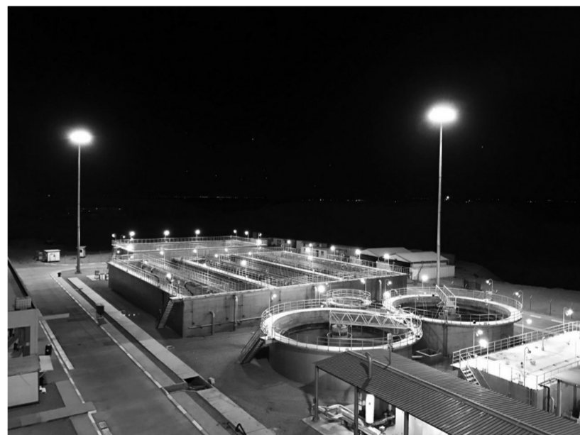
图为伊拉克KAR炼厂四期扩建项目污水处理厂。博天环境供图
