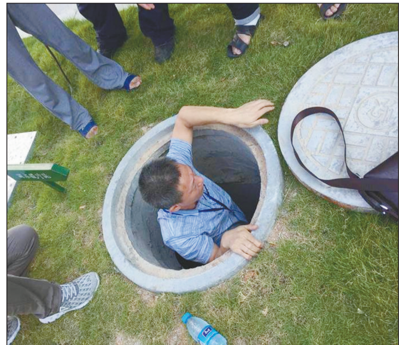
福建省厦门市环保部门采取“三不一直”、错时执法等措施强化日常监管。图为午间休息时段执法人员冒着酷暑进入到企业雨水总口缓冲池并检查应急设施建设落实情况。沈胜学 方丽花摄
