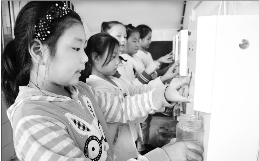
位于南水北调中线水源地的湖北省十堰市郟阳区,近日全面推行国家“全面改薄”中小學生直飲水項目,为郟阳区97所中小學校共免費安裝了直飲水設備,保障學生安全飲水。杨显有摄
