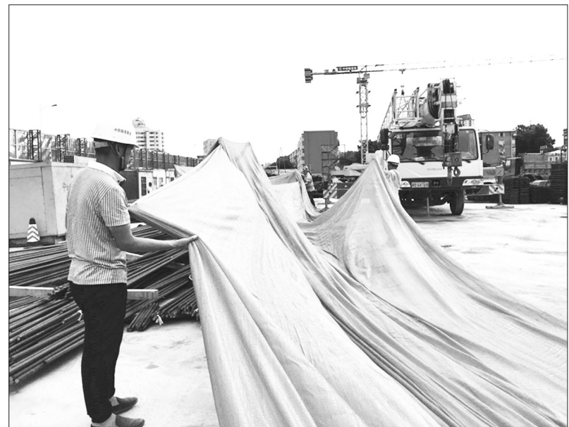
图为天津市河西区一家工地在对天津市环保局大气污染防治驻区服务组指出的问题进行整改。 任效良摄
