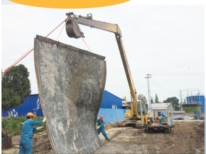
加强污染地块风险管控。发布《污染地块土壤环境管理办法(试行)》,制定实施有关技术规范 and 指南。图为石油化工厂污染地块防控施工现场,工人正在污染地块周边放置垂直屏障设施。
