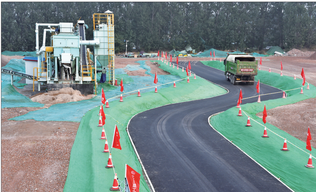
为有效处理北京在疏解非首都功能过程中产生的大量建筑垃圾,北京建资源公司今年启动了朝阳孙河湖改扩还现场建筑垃圾资源化处置项目。据了解,项目可让90%以上的建筑垃圾转化为再生骨料,经过加工后的产品可投入基础设施建设。图为由棚改建筑垃圾生产的材料铺装而成的“环保路”。新华社供图/罗晓光摄
