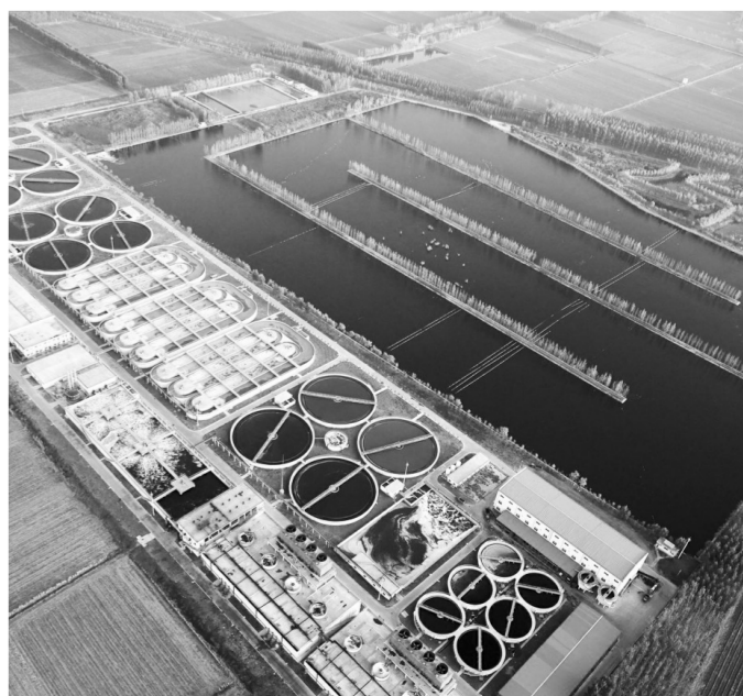
为保护辖区水环境,济宁市不断巩固提升点源治理水平,重点推进造纸、焦化、印染等十大重点行业清洁化改造。图为济宁市太阳纸业8万立方米污水深度处理系统。
