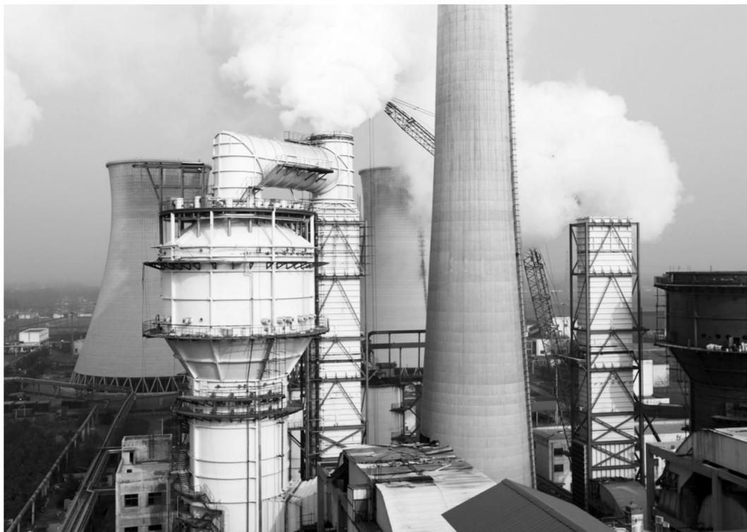
山东省济宁市174台燃煤机组(锅炉)目前已全部完成超低排放改造。图为华能济宁运河发电有限公司5号机组超低排放改造工程。
