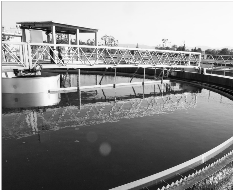
巢湖流域水环境综合治理亚行项目——巢湖南岸污水处理厂日前开始试运行。工程总投资约8300万元,规划服务人口约10万人,日处理1万吨生活污水,出水水质达到《城镇污水处理厂污染物排放标准》一级A标准。按照安徽省巢湖市“十三五”新型城镇化发展规划要求,将以老城区为核心,南北为两翼,构筑“一核两翼”污水处理发展格局,城区污水做到全覆盖、全处理。 本报记者邓佳摄
