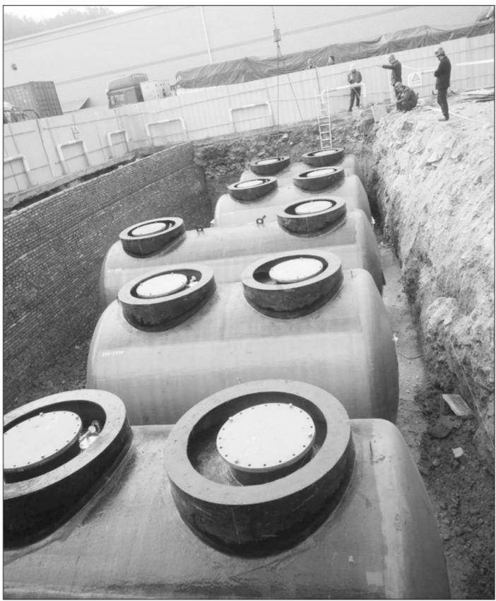
图为中石化十堰分公司东风大道加油站正在更换双层油罐。李洋摄
