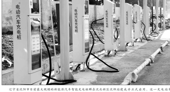
直流桩、交流桩20个,可同时为20台电动新能源汽车快速充电,具备每天为350台新能源电动汽车提供充电 服务的能力。
