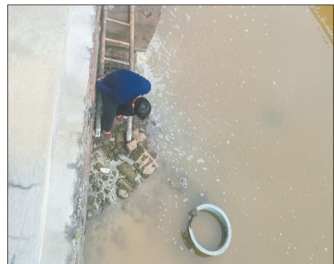
时间:2018年3月1日15:00 地点:江苏省常州市武进区湔里镇生产河
