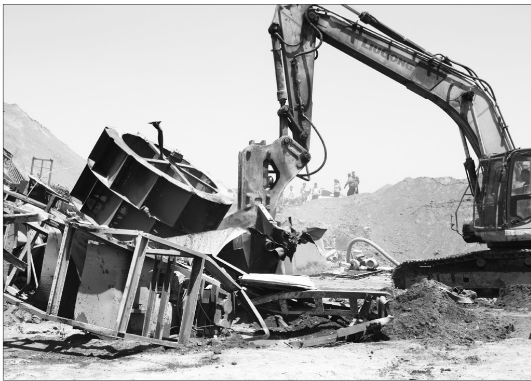
山东省淄博市淄川区与潍坊市青州市日前组织多部门开展淄河流域联合执法专项行动,先后出动68人,大型拆除挖掘设备5台,对河道两侧12处非法洗砂场所进行破坏性拆除,彻底解决这一困扰两地已久的历史遗留问题。
