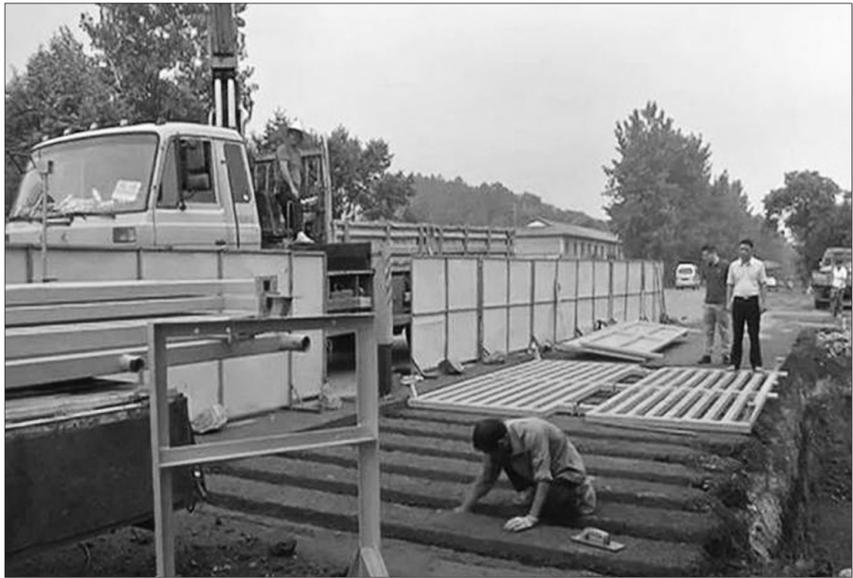
江西省新余市近日在货运车辆进城必经路段建设了6个货运车辆冲洗平台,对进城货车实施强制清洗,解决货车带泥进城、污染城市道路及由此产生扬尘问题。黎燕平摄
