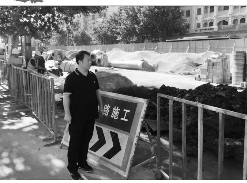
时间:2018年8月24日06:30 地点:天津市宁河区光明路道路施工现场
