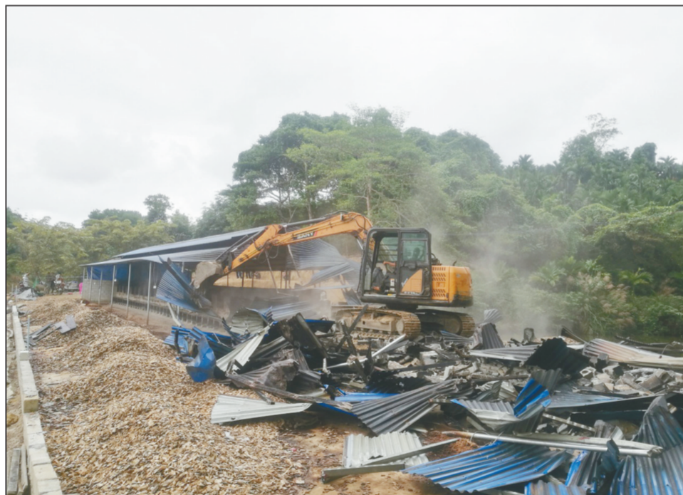
海南省屯昌县与定安县近日加大大气环境跨区域联合执法,强拆交界处219个烟熏槟榔加工点。图为其中一处拆除现场。
