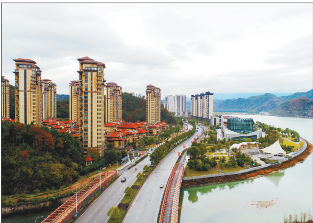
近年来,浙江省台州市仙居县立足生态立县绿色发展,借力项目开发,大力推进“五水共治”,将早年的一片荒凉地打造成山清水秀的美丽家园。如今,位于永安溪之畔的新城区,水清岸美,一幢幢精致的楼房拔地而起,成为当地最美的风景之一。
