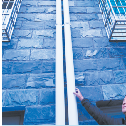
图为浙江省杭州市临安区苕溪人家小区的阳台洗衣机排水“改道”后，从屋顶重新架设的新雨水管，用来收集屋顶雨水并接入雨水管网。管光前摄
