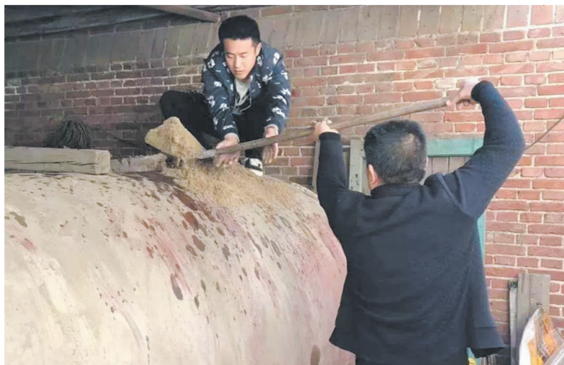
▲图为河北省定州市执法人员正在对黑加油站油罐进行拆沙取締。
