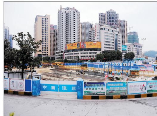
在湖北省十堰市北京路立交桥施工现场,施工方在工地周围采用防尘隔离棚全封闭施工,避免施工噪声对周边环境的影响;施工方还在四周围挡上安装了自动喷淋头,配合施工进行水雾降尘作业,减少粉尘,做到绿色环保施工。薛生摄
