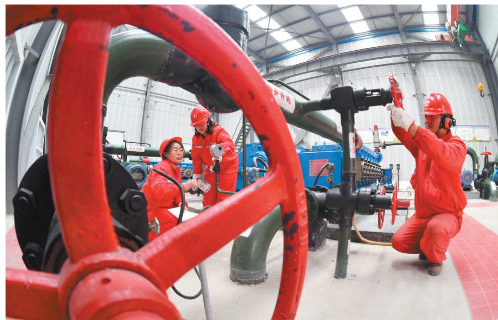
中国石化中原油田濮城采油厂新实施了大排量注水泵替代离心泵节能改造工程。设备既节能环保,又提高注水泵效率,降低注水泵成本。设备累计节约电量近300万度,节约电费成本约230万元。图为技术人员在对置泵房录取生产数据。 马洪山摄
