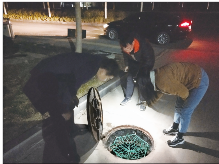
为保障辖区水环境安全,山东省济南市济阳区环保局近日加强了对企业污水及异味排放情况的监管,加大巡查力度,增加巡查频次。图为执法人员夜间出击,打开一企业污水管道井盖查看污水排放情况。
