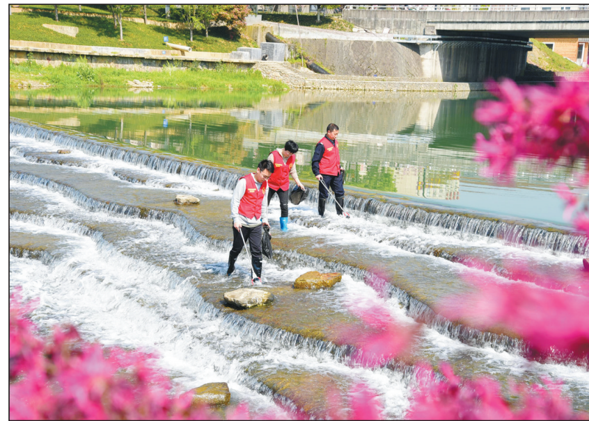
随着主汛期的临近,4月8日,浙江省建德市下涯镇党员青年志愿服务队的年轻干部、党员和志愿者,来到治水第一线的大洲溪河道两岸,检查水利堤坝设施,巡查水质环境,清理水面垃圾,向附近村民宣讲护水知识,确保溪水清澈,河道秀美,设施安全。 人民图片网供图
