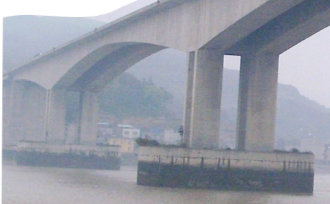
因为用钢渣磨细粉制作混凝土构筑的福天下白石跨海大桥。
