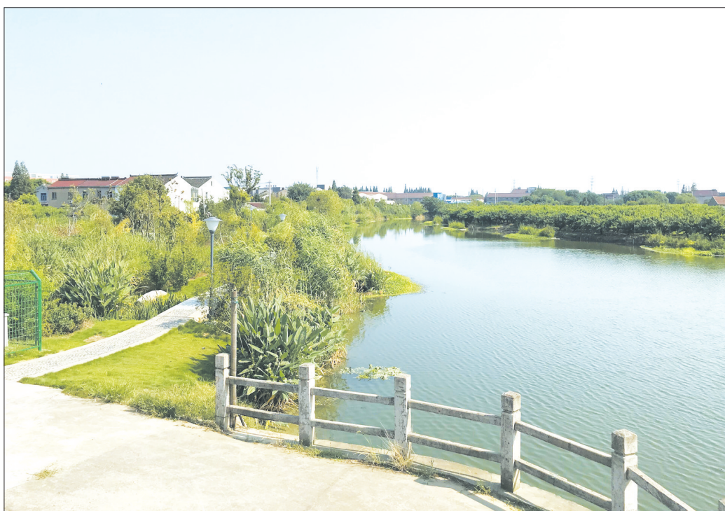
图为江苏省武进区港上河旧貌换新颜。
