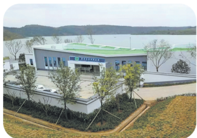
陈家坡水站站房采用庭院式布局,框架结构,耐久年限为50年。配套设施包括一条从站房门口到干线公路的硬化道路、院墙等。站房里面采用灰色面砖和白色涂料,折形女儿墙与周边山体相呼应。它犹如一颗美丽的明珠,镶嵌在汉江之滨,为了一江清水永续北送,为了北中国水井的清洁,倾尽全力守望碧波浩淼的汉江。
