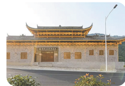
江口站以土家族苗族文化底蕴为基础,站房外观采用了土家族苗族传统吊脚楼建筑模式,采用土家族摆手堂外形,屋顶四角歇山起翘,屋顶呈现双层隔空风格,俱属五柱六挂或五柱八挂的穿斗式木结构,上层宽大,工艺复杂,做工精细鳞次栉比,层叠而上。墙面采用了土家族传统的小青砖进行装饰,具有很高的实用价值和观赏价值,整体设计融合了土家族苗族文化风格,体现了民族和谐团结的乐章。
