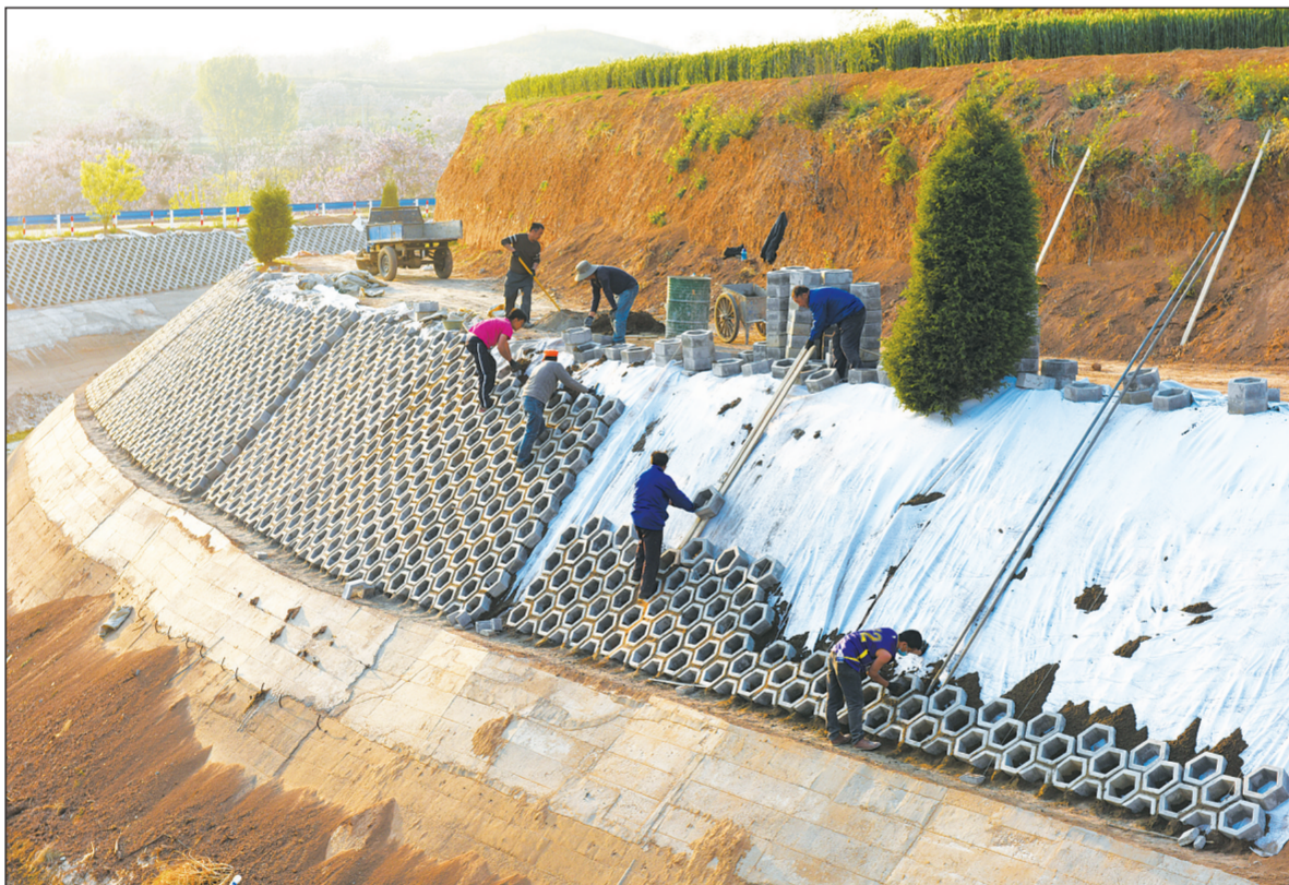
4月12日,在革命老区村、省级扶贫开发重点村河南省孟州市槐树乡岩山村,修渠工人对引沁济骨干渠进行渠道清淤整治和生态保护提升改造,以实现利民渠与景观渠的融合统一。
