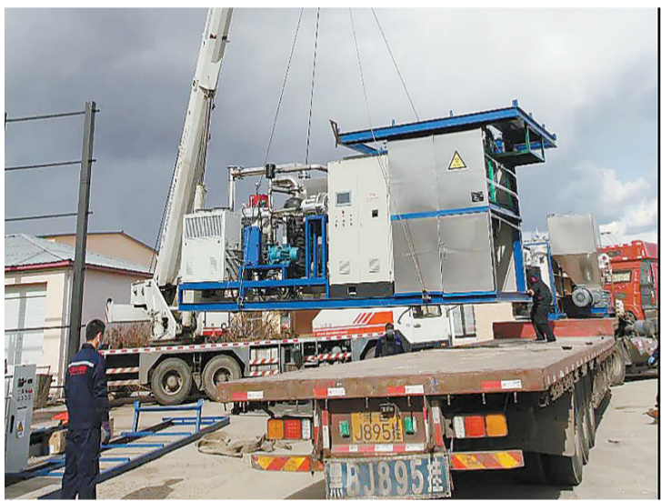
图为工作人员在牡丹江安装医废处置设施。牡丹江市生态环境局供图
