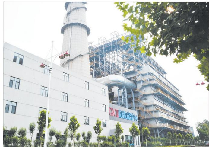
河钢集团在行业首家引进逆流式CSCR脱硫脱硝工艺技术,率先实现烧结烟气超低排放,排放指标居国际领先。魏清源摄
