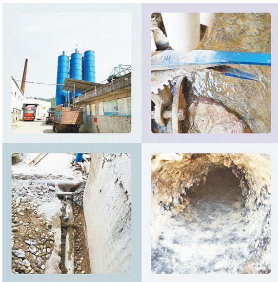
左上图为储存废水的储水罐;右上图为手柄光滑的控制阀门;左下图为埋于水泥地板下的暗管;右下图为抽水管线残留的污泥。
