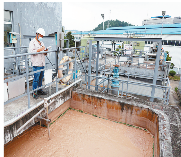
图为欧莱雅宜昌天美工厂投资600万建设的一套“膜生物反应器+反渗透膜+纳滤膜”设备。 邓佳摄
