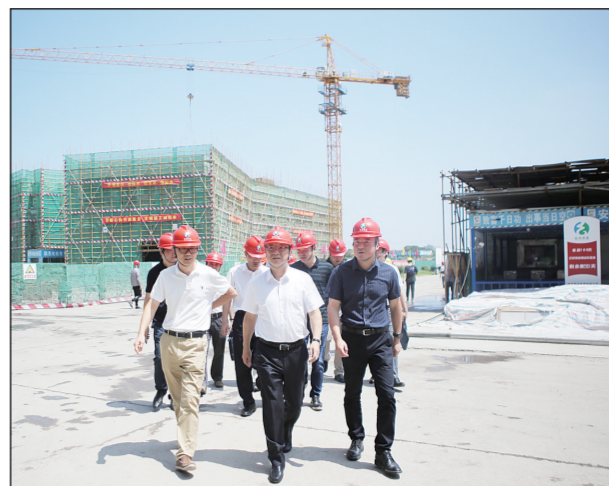
图为项永丹(图中)一行调研拉市海垃圾焚烧项目现场。
