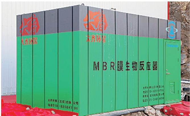
图为野外施工营地抗低温污水处理成套装备——MBR膜生物反应器一体化成套装备。
