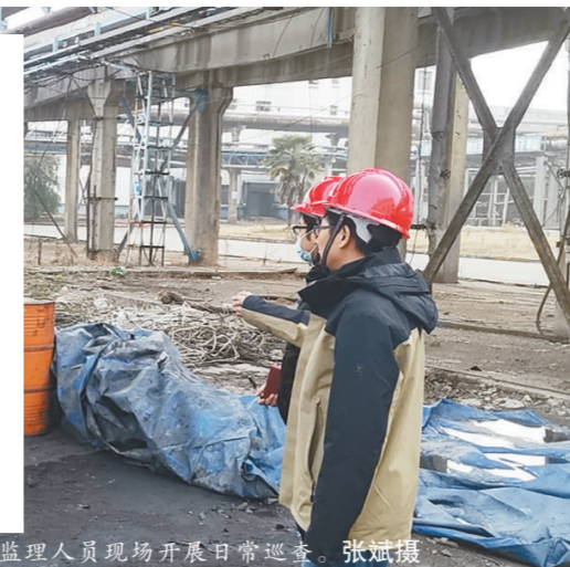
监理人员现场开展日常巡查。张旭摄
