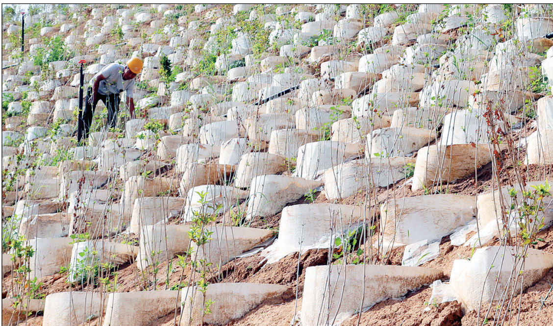
近年来,河北省石家庄市井陘县持续针对过度开采破坏的矿山实施修复绿化提升工程,按照“宜林则林、宜草则草、宜耕则耕”原则,采取人工措施和生物措施相结合的方式,改善山体生态环境。图为井陘县威州镇南固底村的河北省太行山区矿山掌子面治理技术试验项目现场,工作人员在对鱼鳞坑种植的树木进行养护。人民图片网供图
