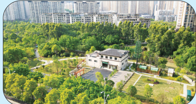
赣州建春湿地公园地理式再生水处理站
