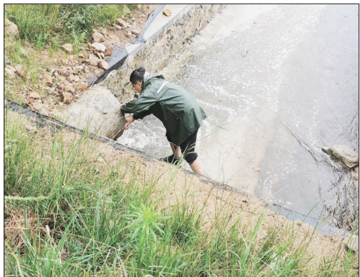
时间:2022年7月12日 地点:山东省威海市环山工业园雨水涵洞
