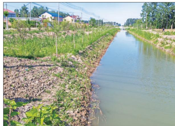
江苏省连云港市灌云县首个农田排灌系统生态化改造试点项目日前投入运行。项目总投资657.65万元,涉及面积1900亩,以大成村等5个行政村高标准农田为基础,结合建设节制闸、灌溉站、生态沟渠、绿化苗木等,构建“农田—排水沟—生态渠—农田”的农田养分循环利用系统。系统可以实现农田灌溉期间关闭闸门,农田退水时,葛蒲、睡莲等植物拦截并吸附水中的颗粒悬浮物及氮磷等;水源短缺时,通过沿线泵站提水灌溉,调控和利用灌溉回水,实现“退水不直排,肥水不下河,养分再利用”。
