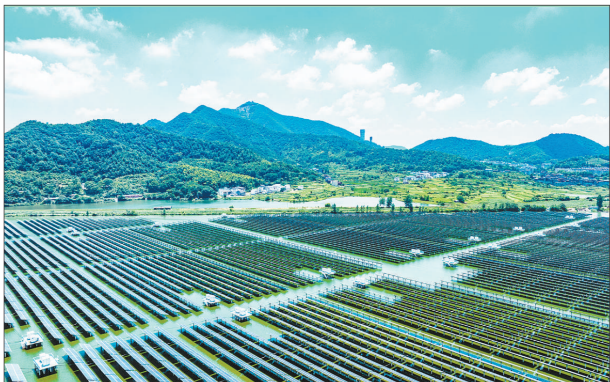
近年来,江西省瑞昌市因地制宜实施渔光互补光伏电站项目,最大限度发挥自然资源效应,打造水上发电、水下养殖的立体化渔光互补发电模式,助力实现碳达峰碳中和目标,带动地方经济、生态双丰收。图为瑞昌市武蛟乡的瑞昌虹源光伏发电站东湖塘,排列整齐的太阳能光伏板与周边景致相映成景,构成一幅美丽的生态画卷。 人民图片网供图
