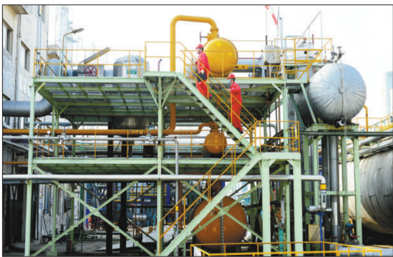
图为中国石化华东石油局已建成的年回收5万吨碳捕集装置。 人民图片网供图
