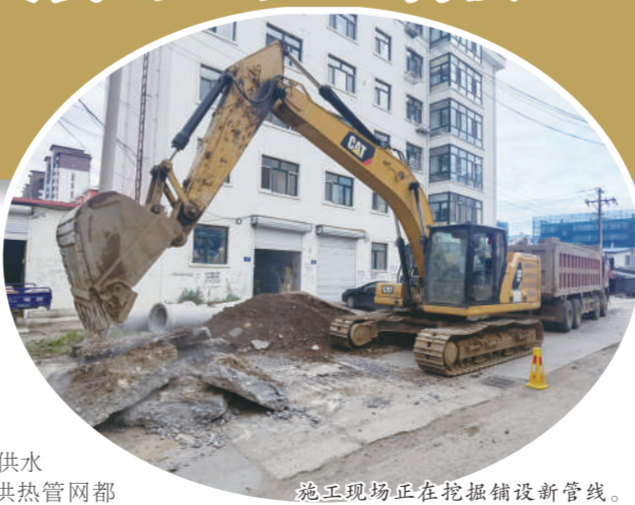
施工现场正在挖掘铺设新管线。
