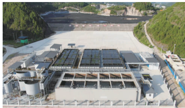
松桃县九龙湖“帷幕法”“生化法”治理工程
