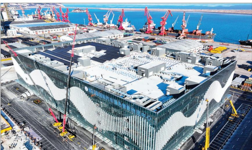
图为江苏连云港国际汽车绿色智能物流中心项目建设现场，项目将建设一座总建筑面积7.4万平方米的5层立体车库，将全部采用AGV机器人自动泊车。 人民图片网供图
